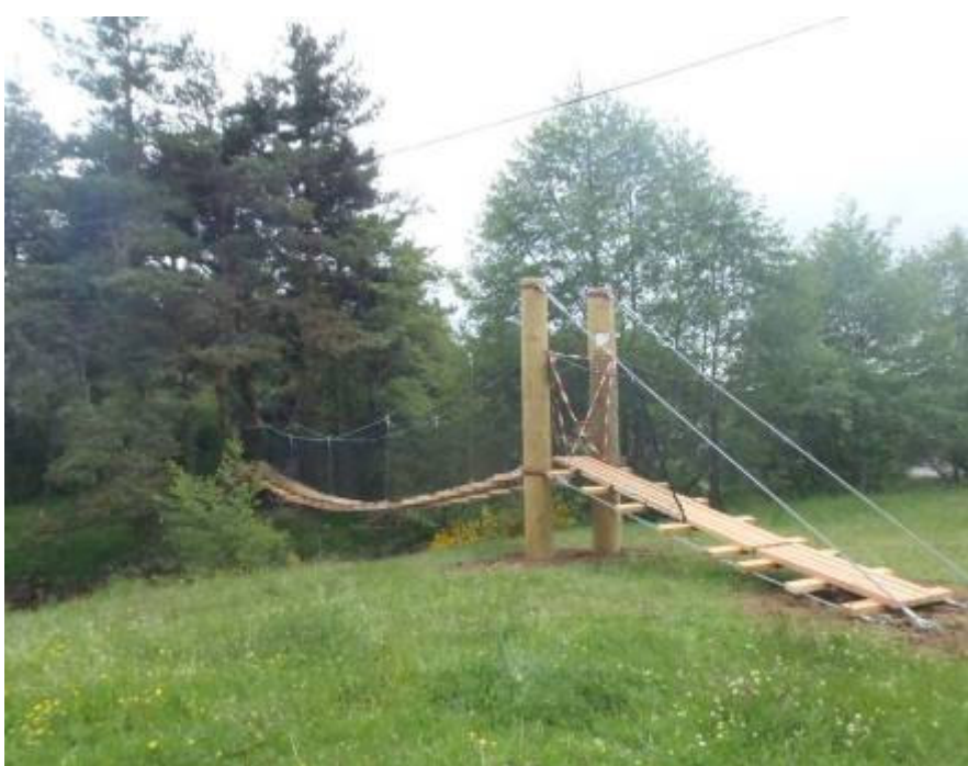
Passerelle piétonne au Lac du Moulinet
