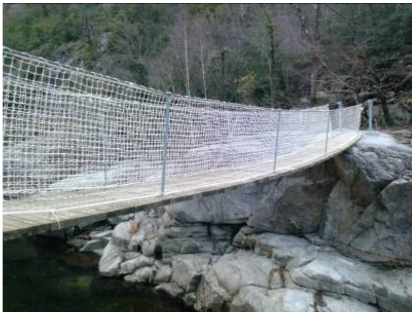
Passerelle piétonne à Villefort
